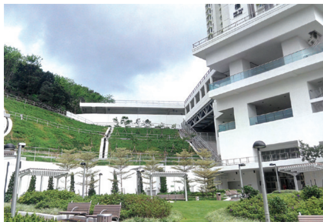
经绿化后的新建斜坡
