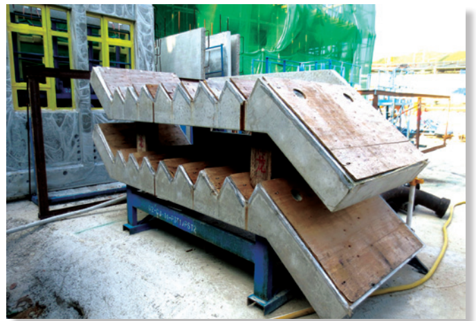
采用预制混凝土部件
