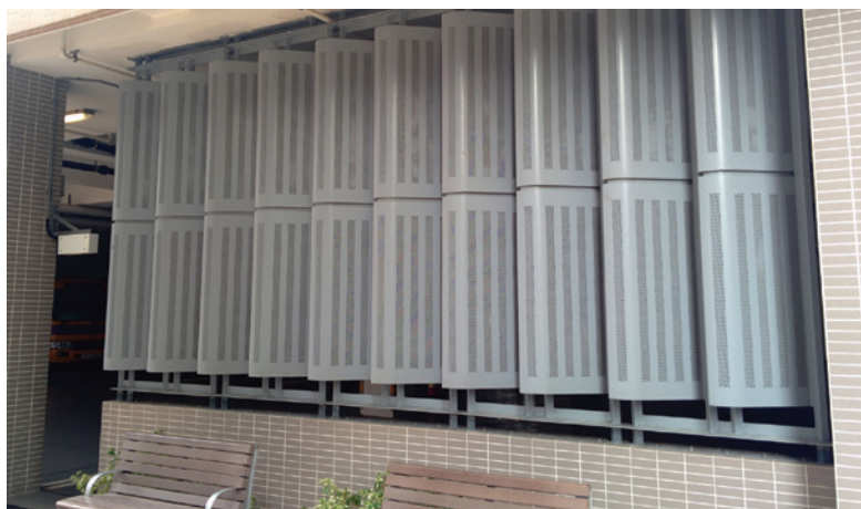
位于长沙湾邨的菇废生物过滤器
