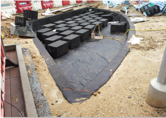
零灌溉种植系统直接输送储存在地下储水箱的雨水灌溉植物
