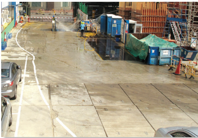
于地盘采用预制混凝土铺设地面进行硬地施工
