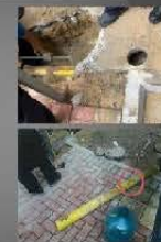
個案 - 進行挖掘工程時擊中地底煤氣設施
