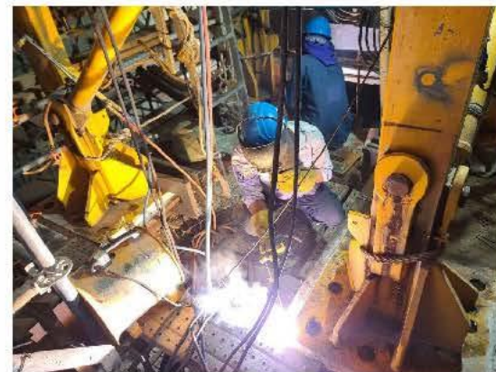
對天秤焊接位進行加焊加固工作
