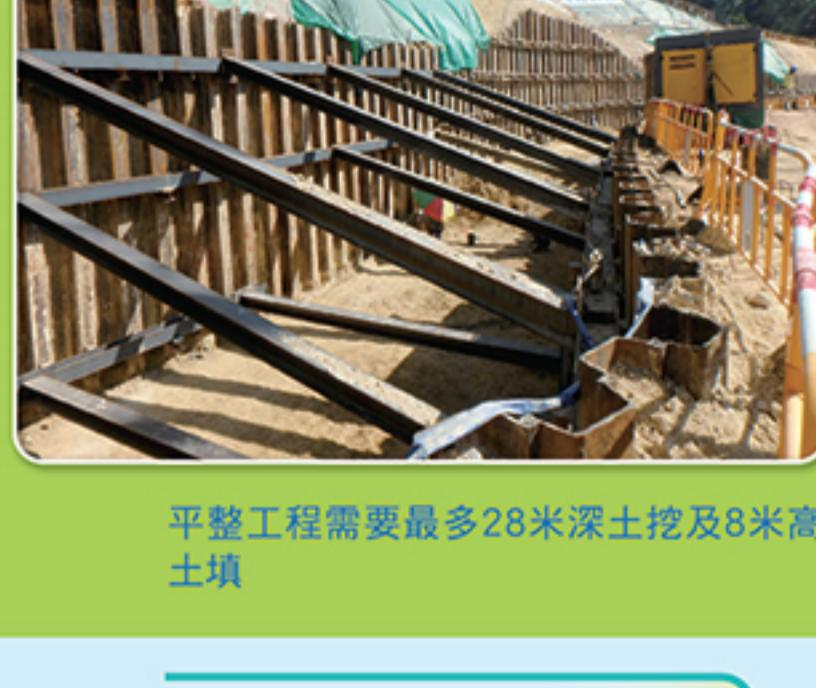
平整工程需要最多28米深土挖及8米高土填
