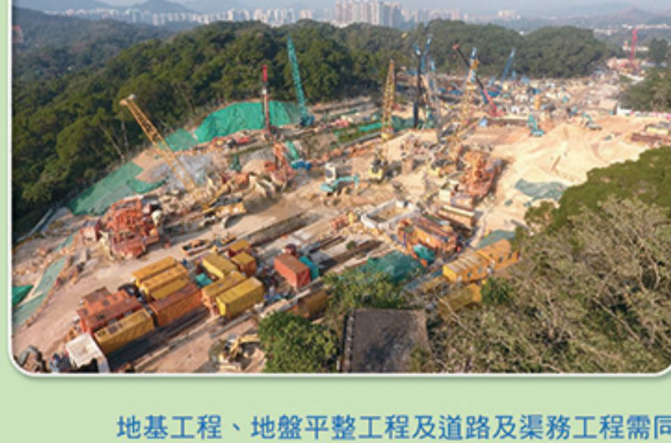
地基工程、地盤平整工程及道路及渠務工程需同時間進行，施工難度大大提高
