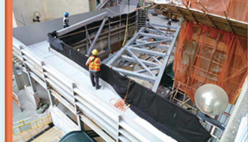
升降機塔底層位置距離青槐樓少於三米，為了盡量減低對居民的滋擾，採取的措施包括嚴密圍封地盤，限定大型吊運於一日之內完成等；此外又大量採用預製組件，以減少佔用工地及燒焊等工序
