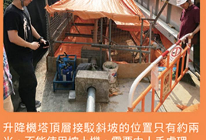
升降機塔頂層接駁斜坡的位置只有約兩米，不能使用挖土機，需要由人手處理
