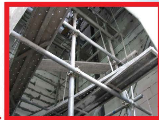
安裝不完整的工作平台 及沒有穩固平台板 ▶
