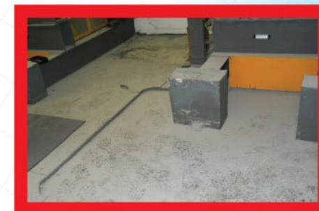
沒有用吸塵機吸走施工時留下的灰塵
