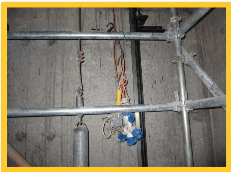
▲ 提供足夠電線掛架以防電線被拉斷
