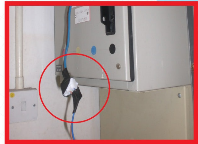
沒有更換損壞的電線
