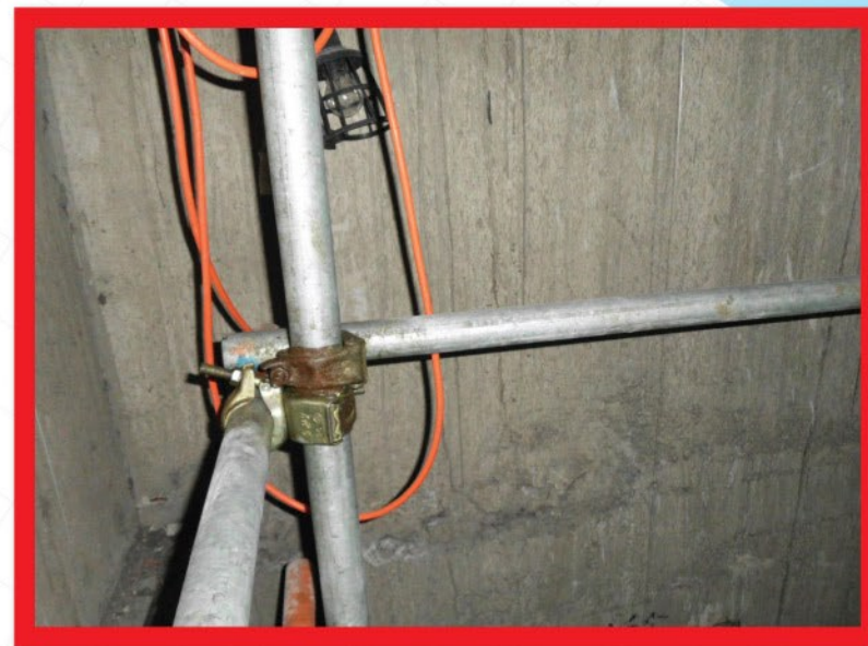
▲ 沒有提供足夠電線掛架以防止電線被拉斷
