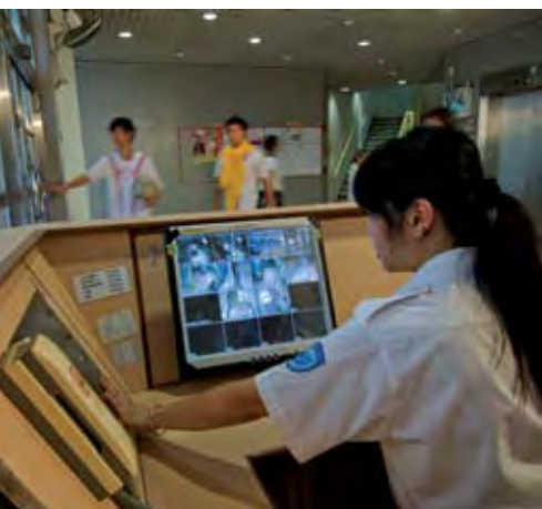
經改善的閉路電視系統配備先進的數碼錄影裝置。
