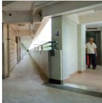
大興邨加裝升降機，令居民出入更方便。
