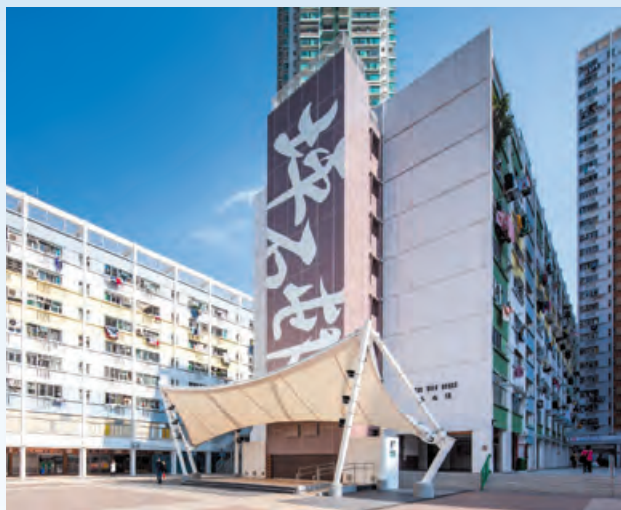
坪石邨新加建的升降机塔。
