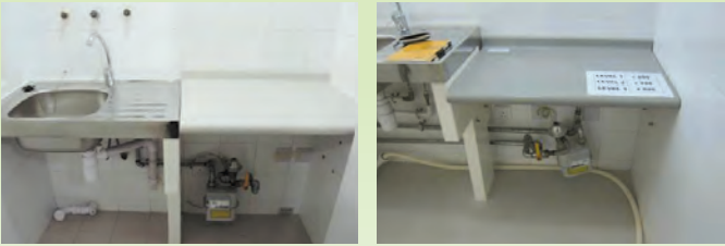
灶台可調校不同高度，切合住戶所需。 下方照片顯示入伙後廚房的擺設。
