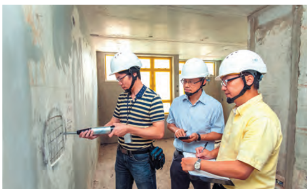
獨立審查組轄下的地盤監察小組正在進行混凝土強度測試。
