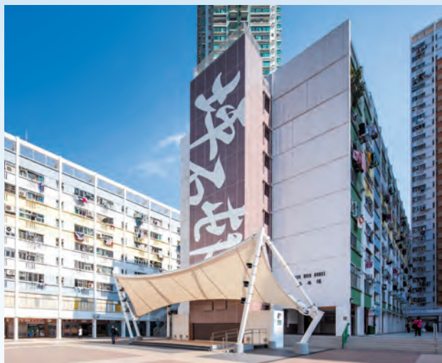
坪石邨新加建的升降機塔。
