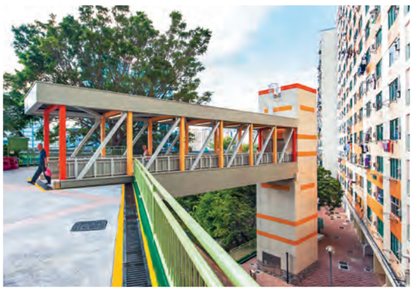
■ 我們為多個公共屋邨加裝升降機，令居民出入更方便。 圖為荔景邨。
