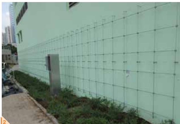
2 新蒲岗景泰苑的预植攀缘植物组件 — 刚安装时(左)及安装数月后
