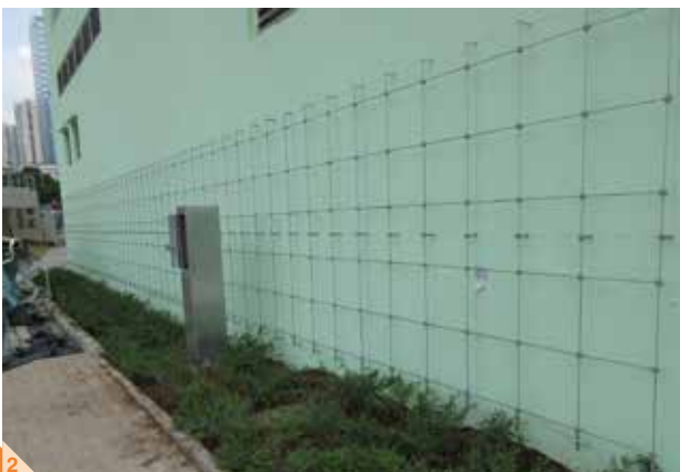
2 新蒲崗景泰苑的預植攀緣植物組件 — 剛安裝時(左)及安裝數月後
