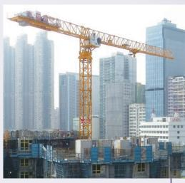
房委會使用機械化建築法和預製組件已逾25年,從經驗所得,這些建築方法既安全可靠,又能提高效率,成效甚為理想。使用預製組件,令房委會維持龐大建屋量;現時標準樓層主要混凝土結構的建築周期為六天,每個單位的人手比率約為0.12工人。
