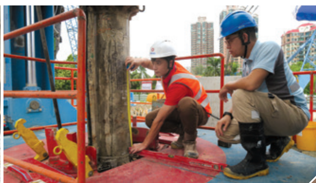
测量地基工程项目的钢套管长度(左)和监督在反循环钻孔机平台上的大口径钻孔桩工程，以确保建筑质素
