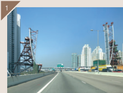
1 连接天桥前 — 结构架矗立公路两旁
