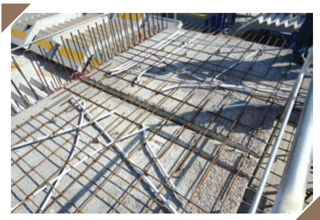
使用半预制走廊楼板的预装电线喉管，增强预制技术
