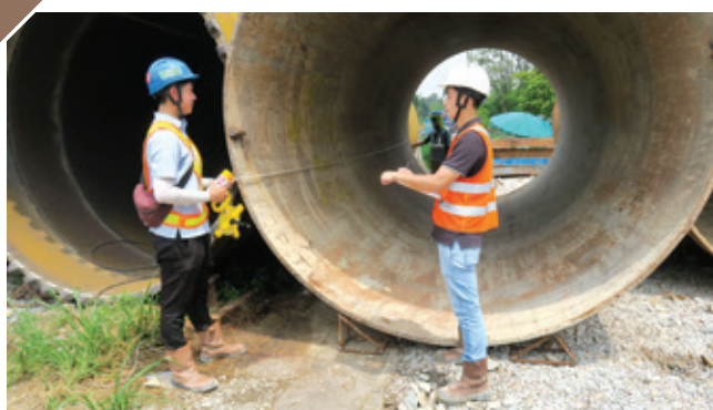
測量地基工程項目的鋼套管長度(左)和監督在反循環鑽孔機平台上的大口徑鑽孔樁工程，以確保建築質素
