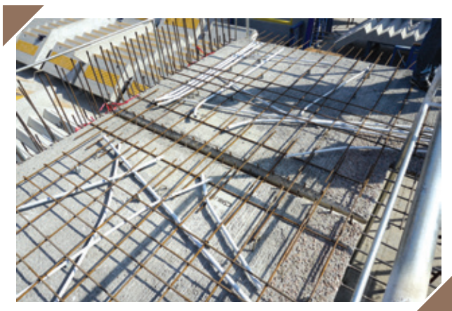
使用半預製走廊樓板的預裝電線喉管，增強預製技術
