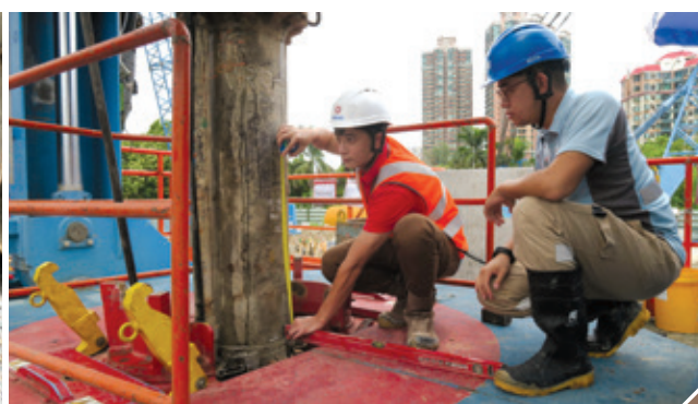
測量地基工程項目的鋼套管長度(左)和監督在反循環鑽孔機平台上的大口徑鑽孔樁工程，以確保建築質素
