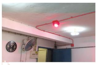
公屋單位內的「火警視像警報系統」閃動 Flashing of a visual fire alarm system inside a PRH flat
