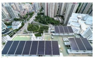
□ 啟鑽苑連接電網的光伏發電系統
