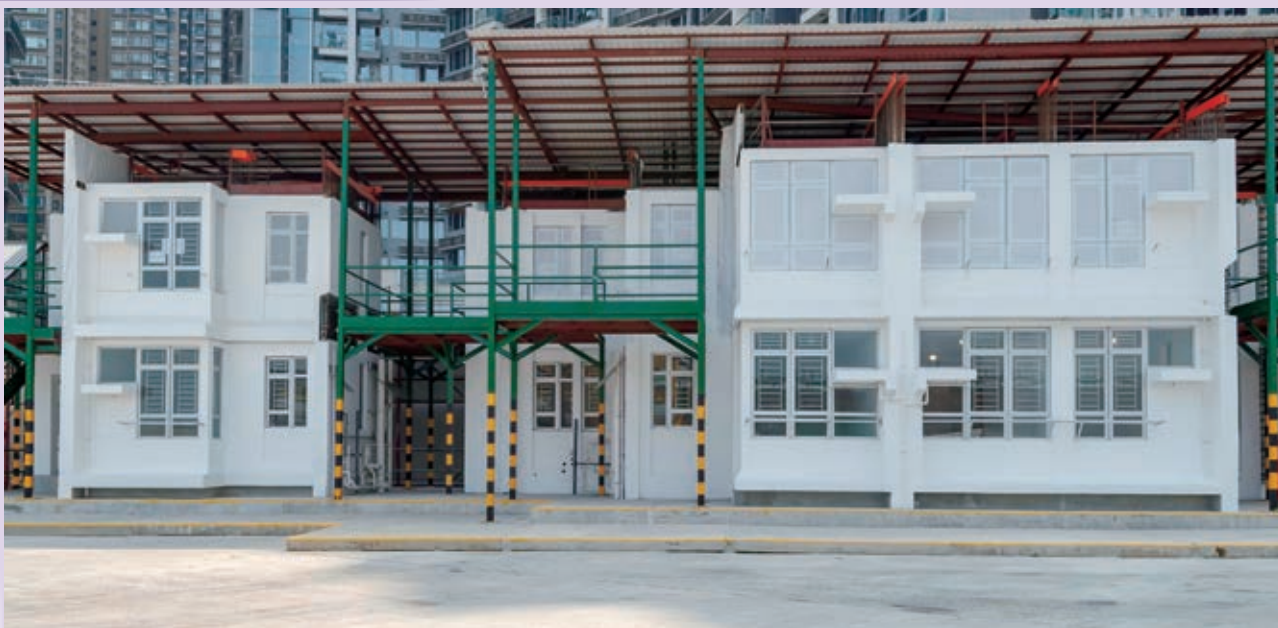
東涌第99區的「組裝合成」模擬搭建單位 The MiC mock up in Tung Chung Area 99
