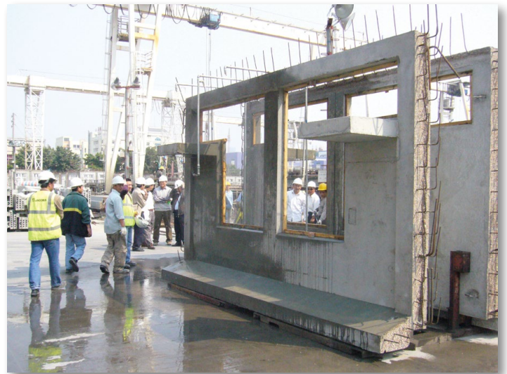
预制混凝土外墙以矿渣微粉取代部分水泥
