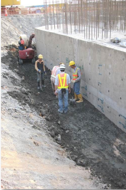
以水泥加固的海泥作回填物料
