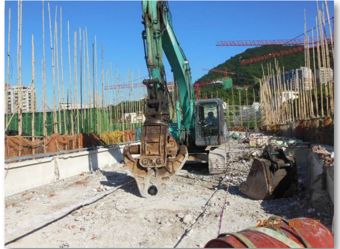
于工地采用液压混凝土压碎机
