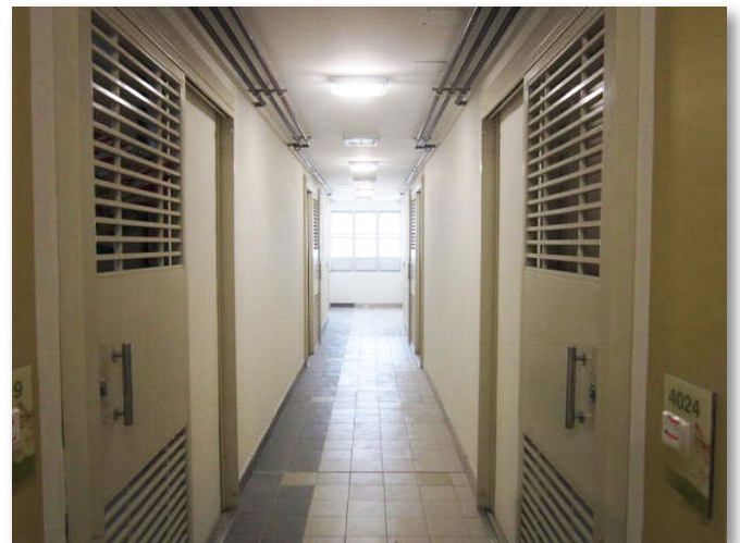
启晴邨的LED照明装置
