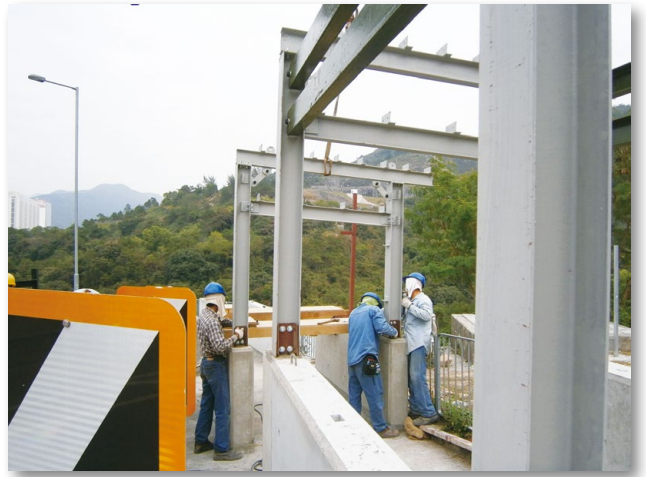
安达臣道地盘的可再用组件式围板
