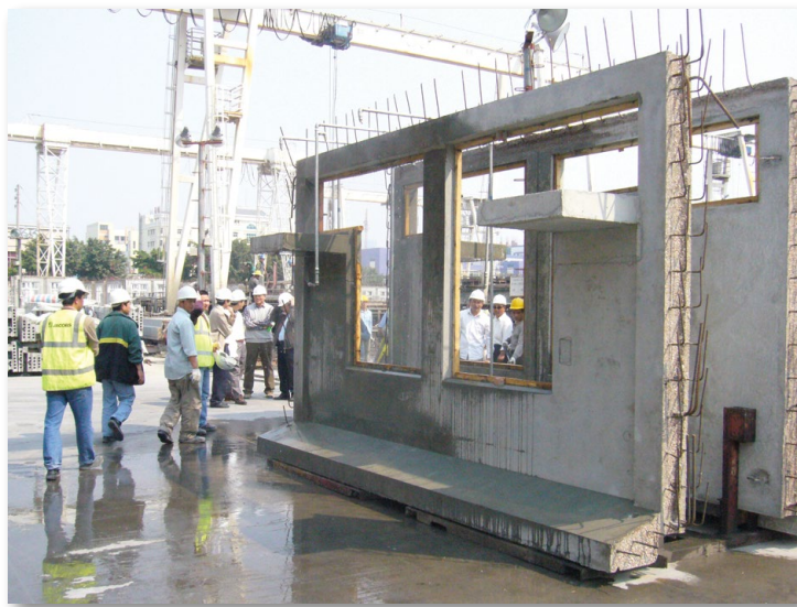
預製混凝土外牆以礦渣微粉取代部分水泥
