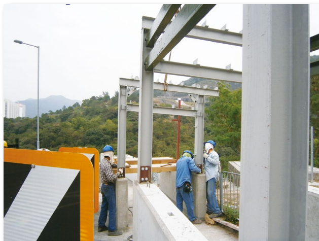
安達臣道地盤的可再用組件式圍板
