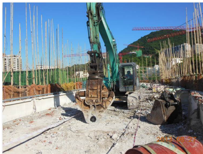
於工地採用液壓混凝土壓碎機
