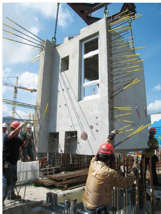
啟德第一乙區的立體預製浴室
