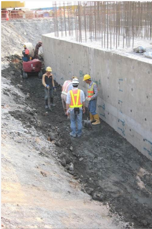
以水泥加固的海泥作回填物料
