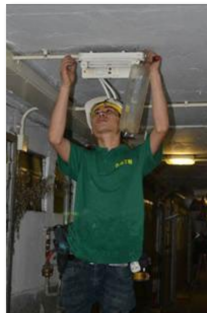
安裝節能電子鎮流器
