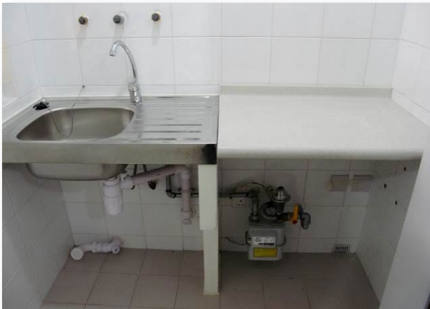
高分子聚酯樹脂灶台設有三段高度可供調校
