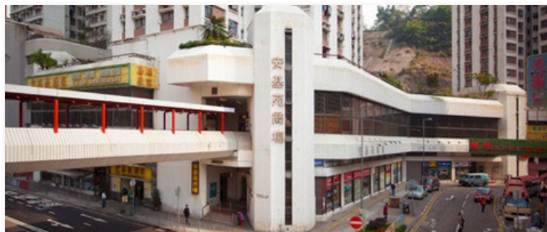
安基苑零售設施提升工程及坪石邨的主要改善工程
