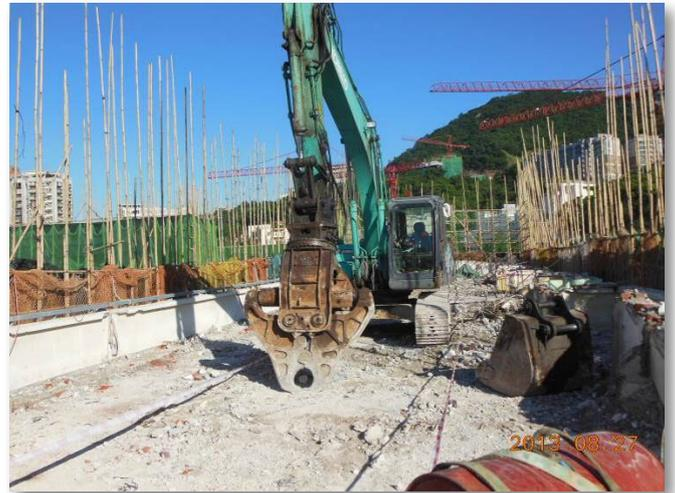
於工地採用液壓混凝土壓碎機
