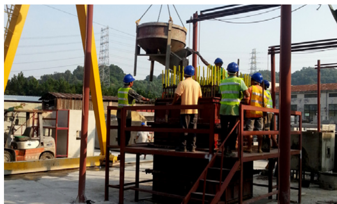
水泉澳一期的预制沙井
