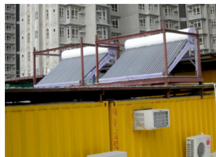
工人淋浴间安装太阳能热水器
