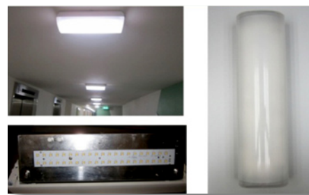
启德第一甲区试验安装LED凸面照明器
