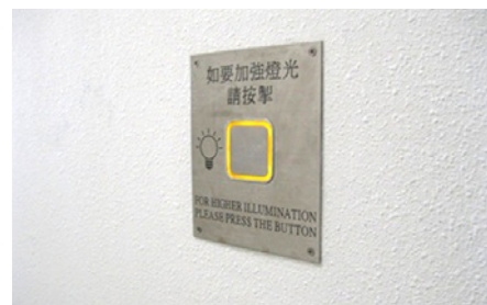
两级光度照明控制系统的手动开关按钮
