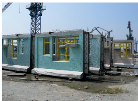
使用预制混凝土组件
