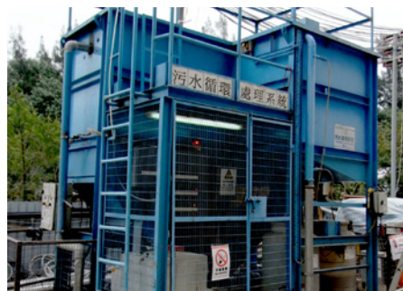
强制安装污水循环处理设施
