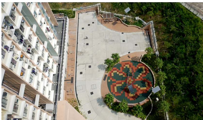
葵涌大白田街新建斜坡的绿化工程
