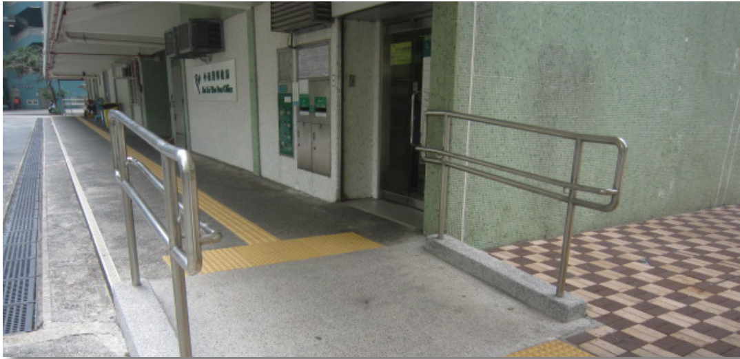
小西灣邨的無障礙通道改善工程
