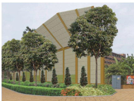
建造隔音屏障在傳播路徑降低噪音
