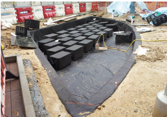
零灌溉种植系统利用毛细管作用，直接输送储存在地下储水箱的雨水灌溉植物
