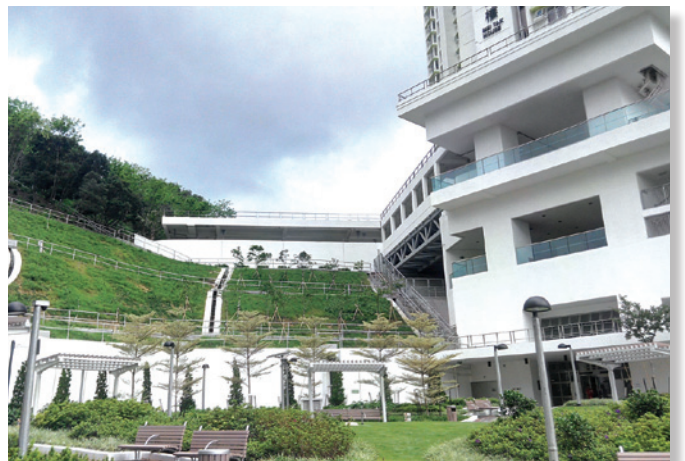
经绿化后的新建斜坡
