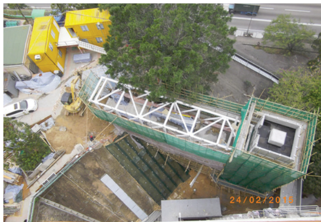
丽瑶邨兴建中的升降机装置及行人天桥
