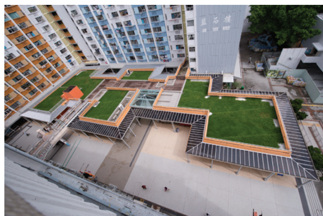
位于坪石邨的绿化天台
