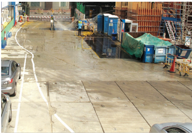
於地盤採用預製混凝土鋪設地面進行硬地施工
