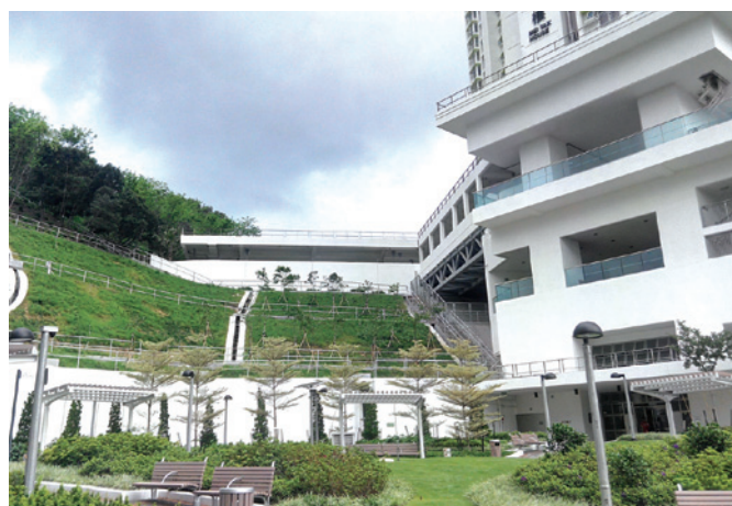
經綠化後的新建斜坡
