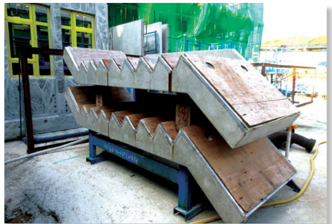
採用預製混凝土部件
