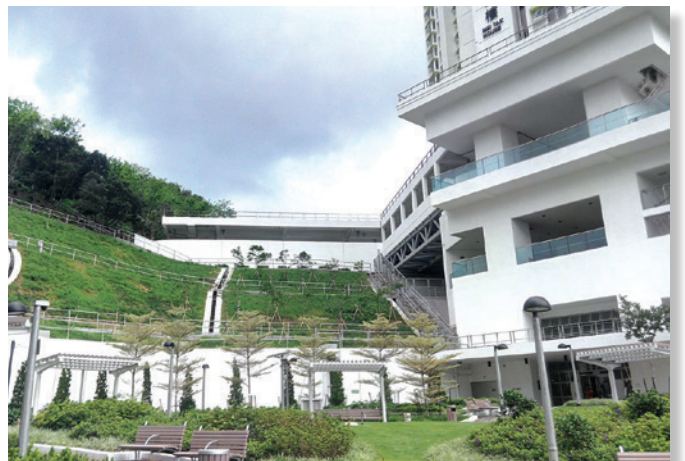
經綠化後的新建斜坡
