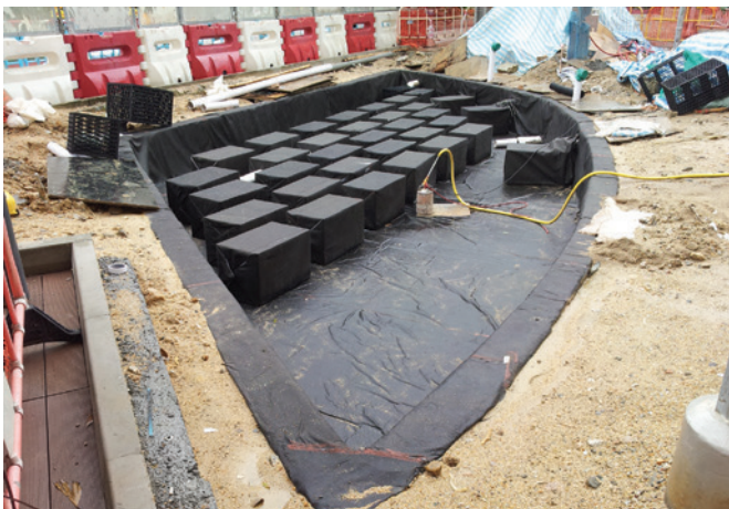
零灌溉種植系統利用毛細管作用，直接輸送儲存在地下儲水箱的雨水灌溉植物
