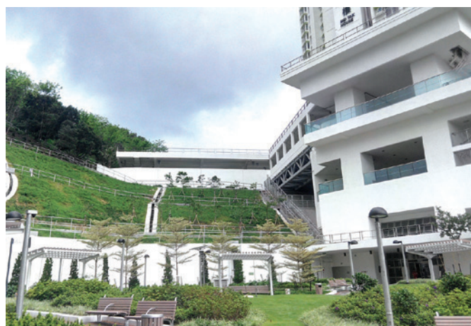
經綠化後的新建斜坡
