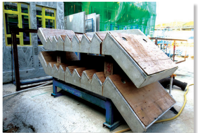
採用預製混凝土部件
