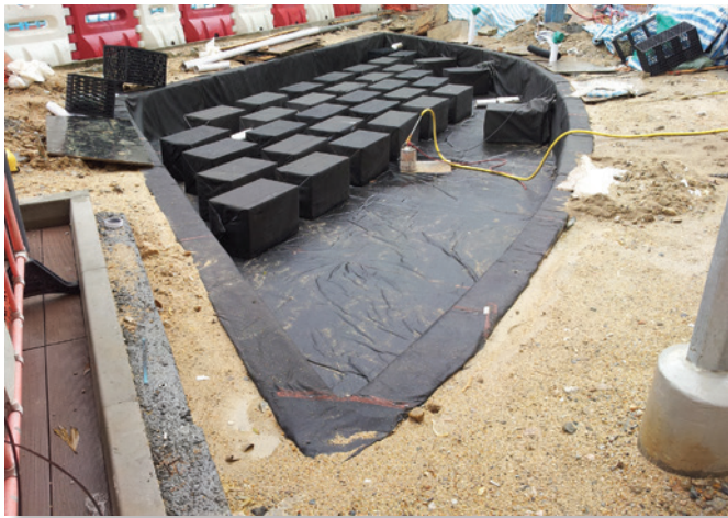
零灌溉種植系統直接輸送儲存在地下儲水箱的雨水灌溉植物
