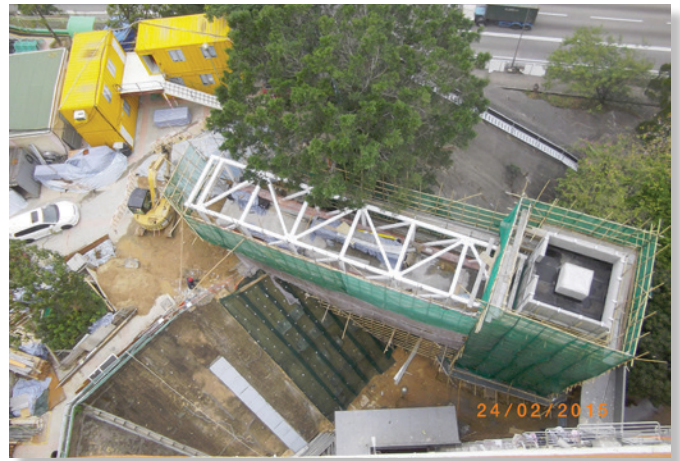
麗瑤邨興建中的升降機裝置及行人天橋
