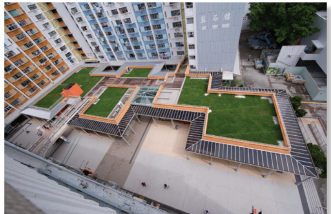
位於坪石邨的綠化天台
