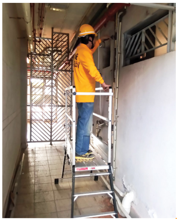
▲ 更换公共屋邨公用地方喉管的工程
