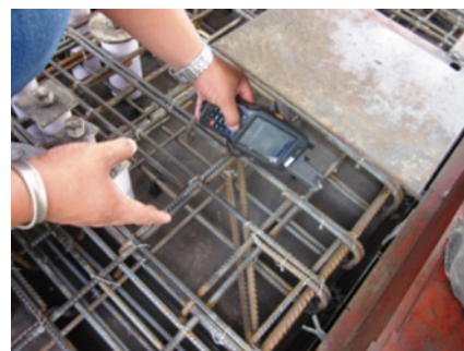
◆ 无线射频识别技术用于追查建筑组件运送过程以及建筑地盘废料处置情况
