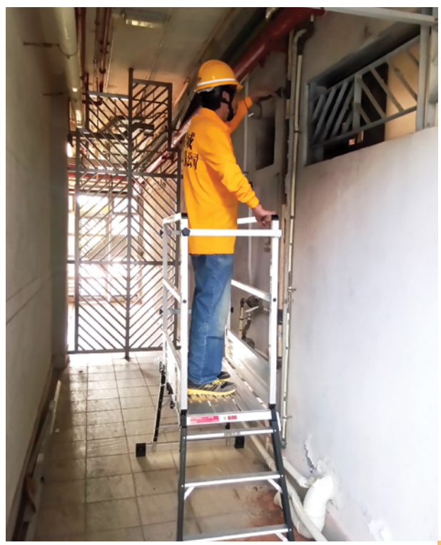
▲ 更换公共屋邨公用地方喉管的工程
