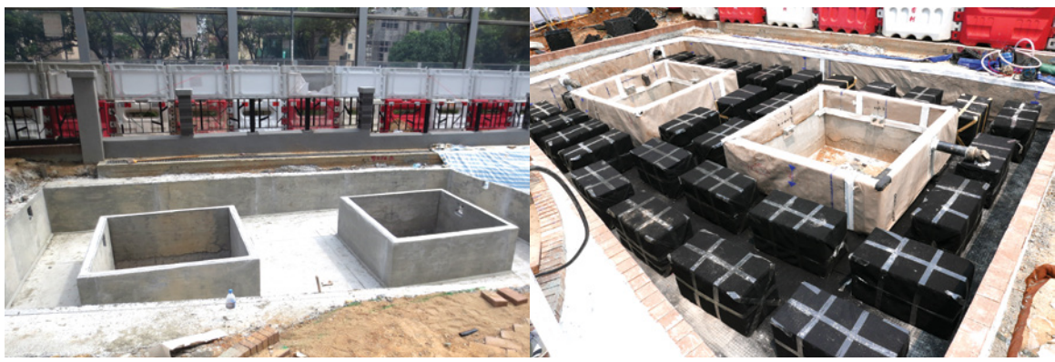
▲ 零灌溉系统：准备中（左图），施工中（右图）
