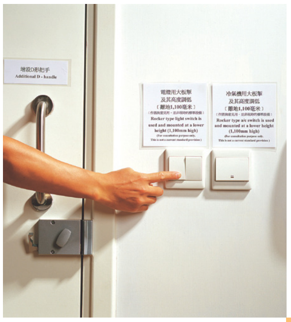
▲ 所有固定装置和配件都可以轻松安全地操作，对使用步行架和轮椅的老年人都不构成阻碍
