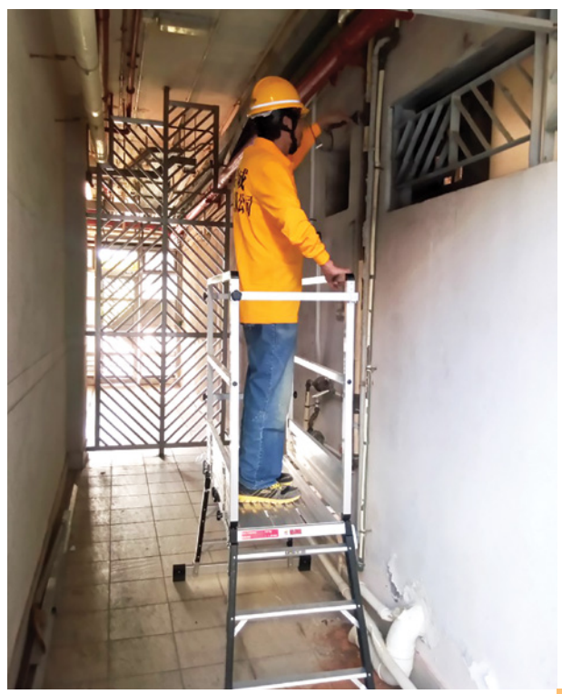
▲更換公共屋邨公用地方喉管的工程
