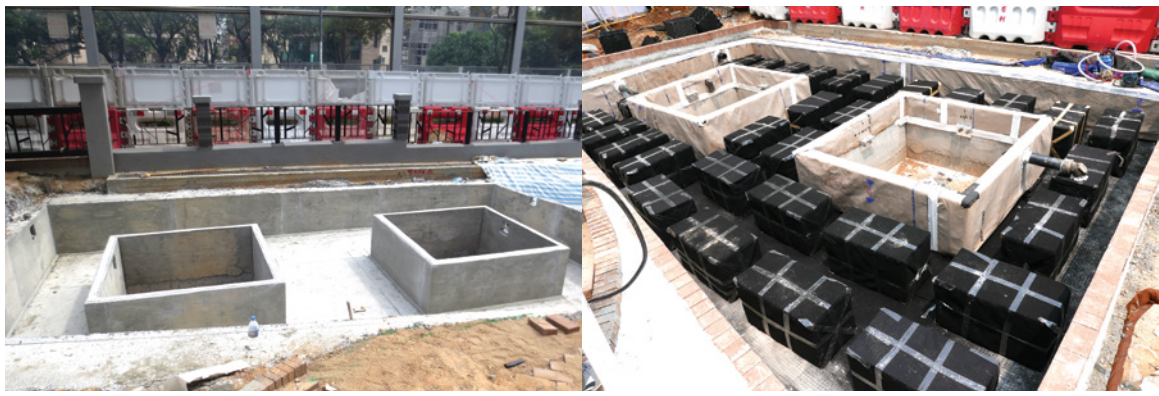
▲ 零灌溉系統：準備中（左圖），施工中（右圖）
