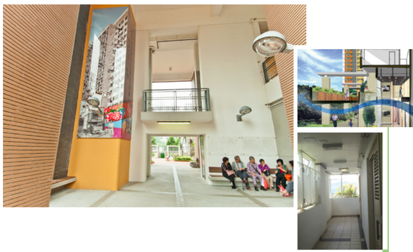
▲ 我們項目中配合天然環境設計的例子：採光中庭（左）；通風走廊（右上）；採用天然光的走廊（右下）
