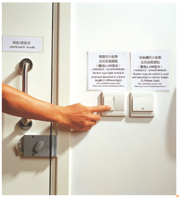
▲ 所有固定裝置和配件都可以輕鬆安全地操作，對使用步行架和輪椅的老年人都不構成阻礙
