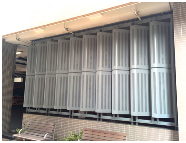
▲ 長沙灣邨的菇廢生物過濾系統
