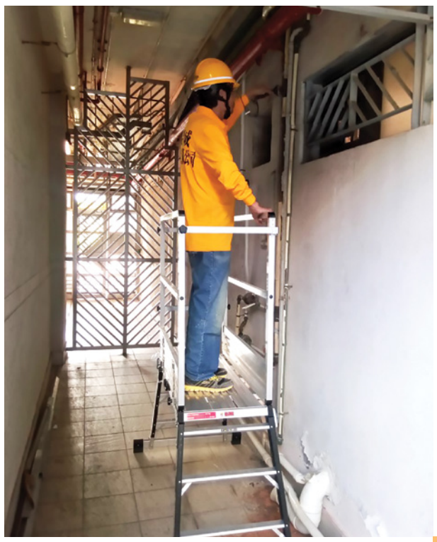
▲更換公共屋邨公用地方喉管的工程
