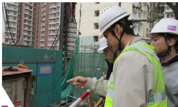
房委会人员突击巡查工地，确保承建商和项目团队保持安全警觉
