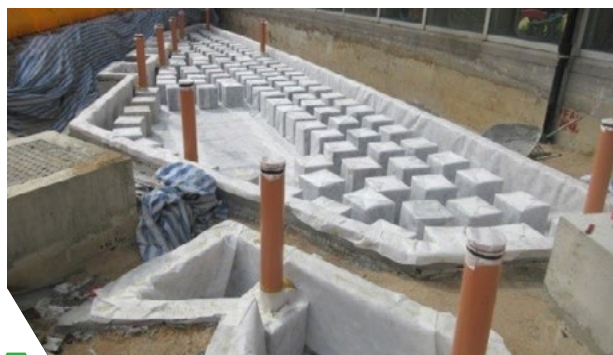
零灌溉系統透過儲存和抽取雨水作灌溉以達至自給自足的循環：完工前（左圖）和完工後（右圖）
