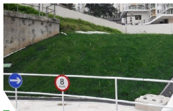
蘇屋邨第二期斜坡上的噴草
