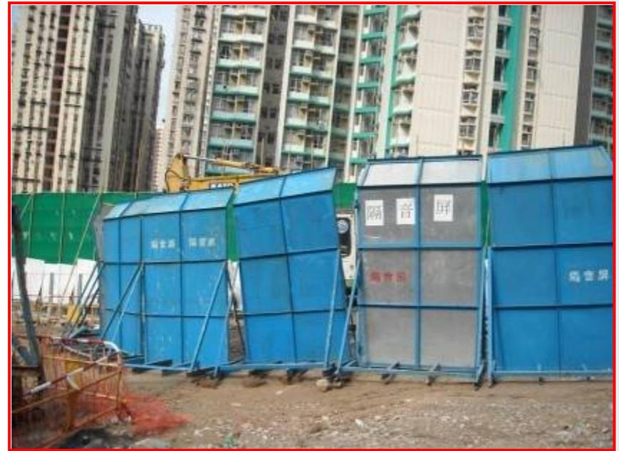
隔音屏採取U字放置方式，包圍打石裝置
