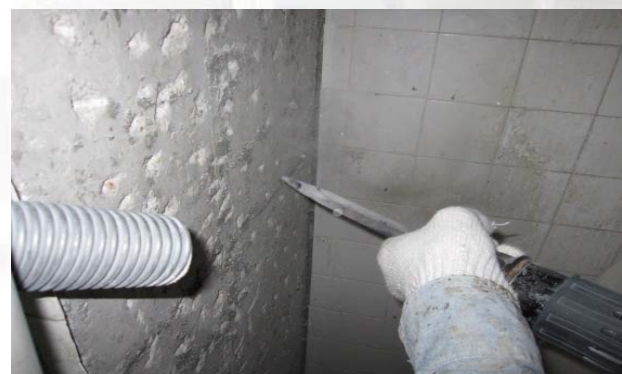
使用吸塵機即時吸走塵埃
