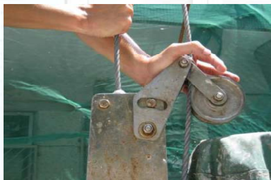
步驟 3: 檢查及測試制動裝置
