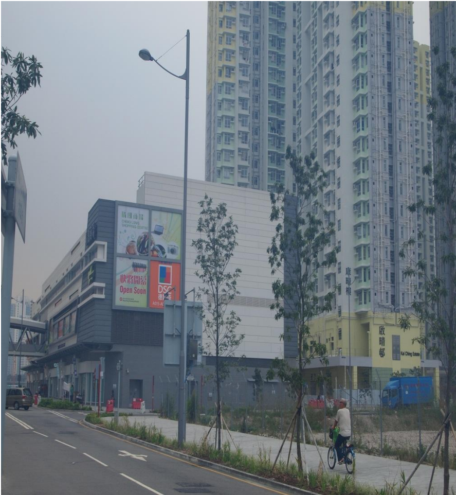
啓德發展區1A第1及2期(啓晴邨)及商場(啓晴商場)之電力裝置工程
