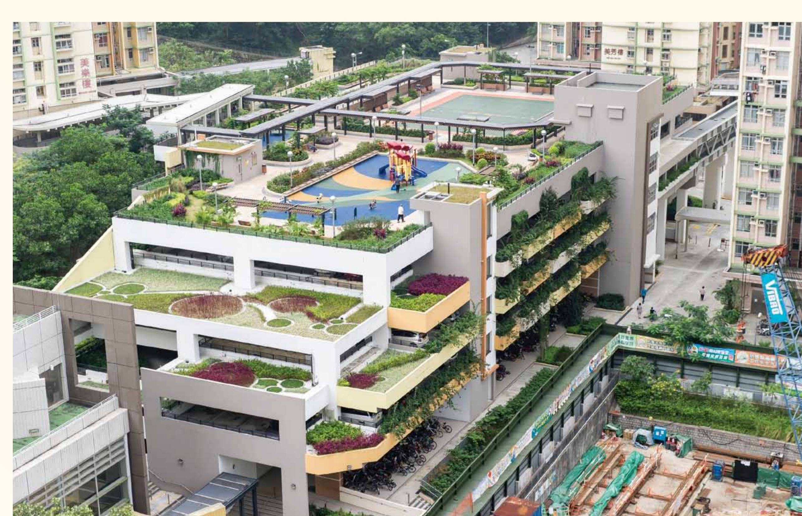
多層停車場梯級狀的綠化屋頂，花槽及天台花園為社區增添生氣
