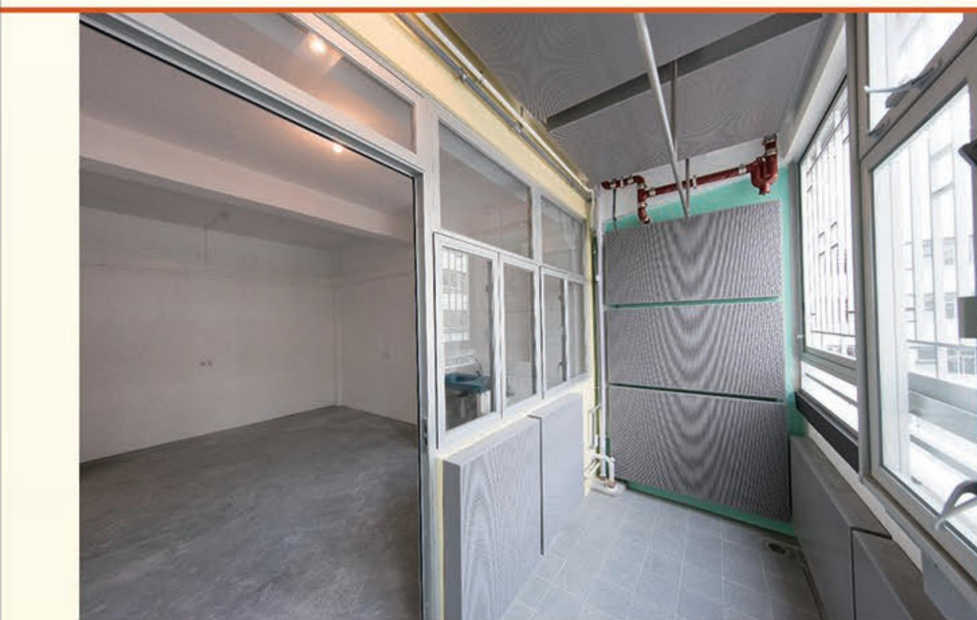
◀ 減音露台裝上吸音板及隔音屏，可減低噪音進入室內。最高可減噪音達9分貝(A)
