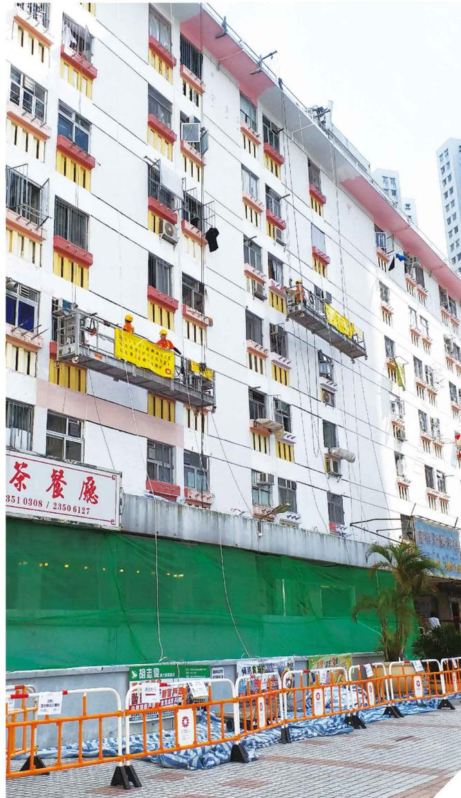
在**施工**方面，我們提倡**施工**工地安全，包括使用圍欄及圍網將工地範圍圍封，避免公眾人士誤闖工地。所有外牆吊船工作人員均接受安全訓練，吊船不准超載，工友需配帶安全帽和帽帶、安全帶及扣上獨立救生繩才能施工，每組吊船均定期檢測及配有獨立救生繩。
