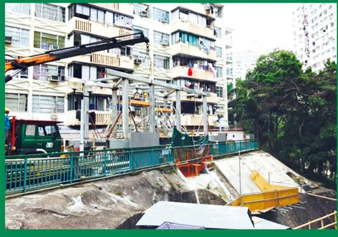
礙於地形及運輸通道的局限，地盤需以吊重機來搬運建築物料及器材。
