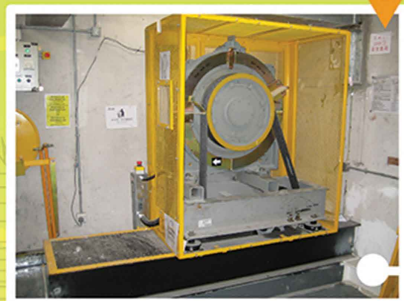
現代化工程後的升降機曳引機
