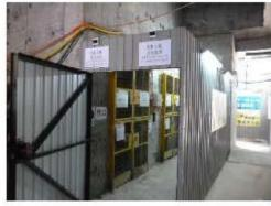
為了有效監控合資格操作員 ,工地于吊船/進入較井使用 RFID系統。獲授權工友必須 使用RFID卡與鑰匙來啟動吊 船或進入較井。
