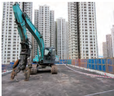
使用低噪音液压器械进行拆卸工作 Low noise hydraulic breaker for demolition works
