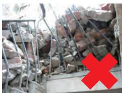
泥石堆积和可能掉落泥石 Accumulation of debris
