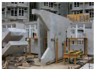
以钢架稳固地承托预制组件
