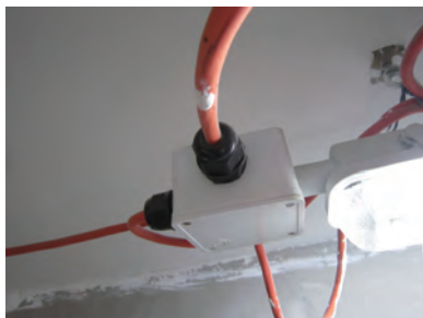
装置需有保护带电的部分，防止意外被触及 Live parts protected/insulated
