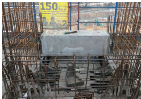
提供一个安全的工作平台上进行固定预制混凝土横梁后,才进行吊运 Working platform for fixing precast concrete beams
