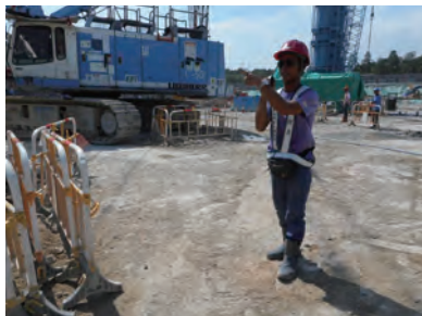
讯号员手持电子通讯仪器，确保吊运过程顺利/安全。
