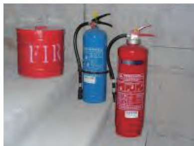
在梯间适当的位置提供灭火筒／灭火沙桶 Fire extinguisher/sand pack at staircase
