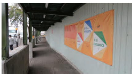
以围板覆盖的安全行人道 Safe walkway under hoarding
