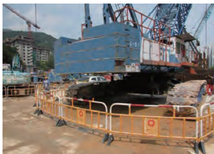
围栏用以阻止其他人等进入正在工作中的重型机械的范围
