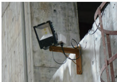
在室外安装的照明装置，需选用有防水功能的型号 Waterproof lighting at external area
