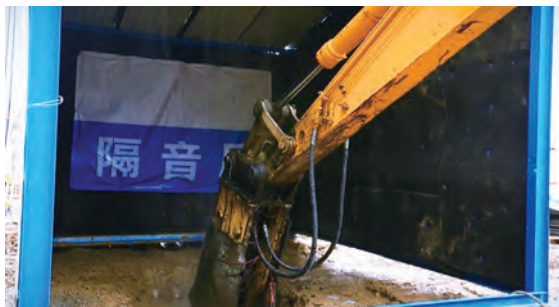
使用隔音屏阻隔产生的噪音 Noise shelter to screen the noise generated
