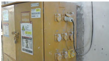
最终电路不得有电缆接头 No cable joint in the final circuits
