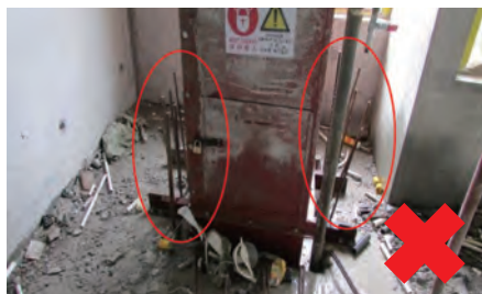
没有保护突出的钢筋
