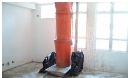
给突出的钢筋提供安全保护
