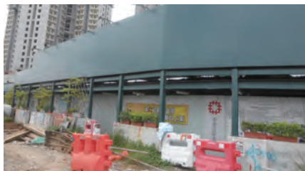
在行人上架设双层围板 Double-deck hoarding over pavement
