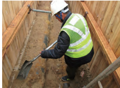
工人以人手挖掘，以免意外损毁公用设施。 Hand digging to avoid accidental damage to utility
