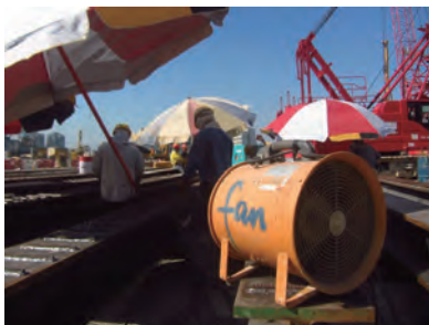
使用风扇／吹风机保持工作地点空气流通 Adequate ventilation for the works area by fans or blowers
