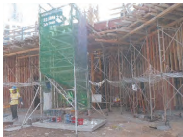
工作架上装设安全网，减少人体下坠时所受的伤害
