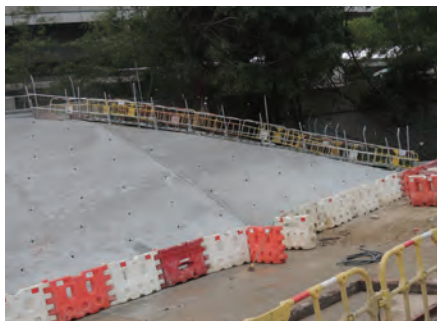
为大型挖掘工地提供适当的出入口 Adequate access and egress from mass excavation
