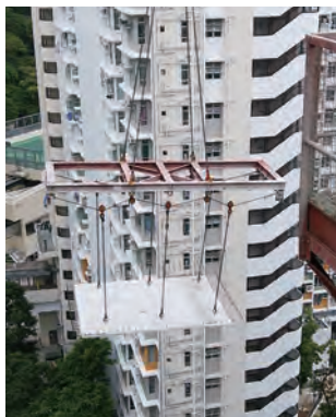
在吊运预制楼面板时，须正确安全地稳系吊钩于吊架上，才进行吊运 Fix properly anchor points of precast concrete slab to lifting frame
