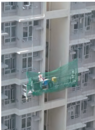
为吊船上延迟燃烧物料造成的保护幕，以避免物料从高处下堕
