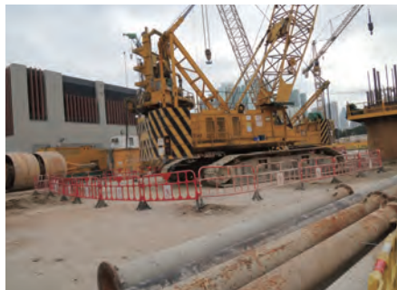
以围栏设立一个可分隔的作业区 Barrier set up to separate the works area
