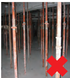
撑杆之间未有以系条联系 No tie to props
