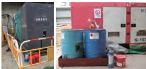
发电机装置旁，应放置灭火器具
