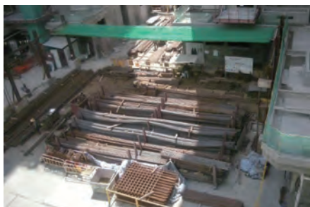
为扎铁场提供伸缩性保护网 Foldable net provided above bending yard
