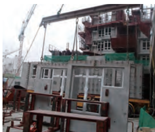
使用有足够支持点的工字起重梁给预制外墙固定后，才进行吊运 Hoisting I-beam with supporting points to lift precast concrete facades
