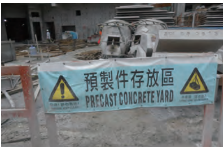
在铺设硬地面的地方存放预制混碍土组件 Hard paved areas for storage of precast concrete products
