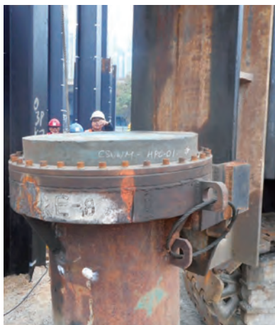
加设吊索以提升安全度（桩锤头）
