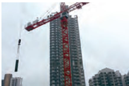
架设中的塔式起重机 Erection stage of tower crane
