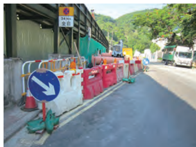
使用防护围栏，划出一个安全的工作地带 Protection barriers used to ensure a safety working zone
