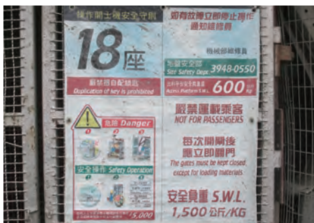
张贴安全操作荷载及安全使用物料吊重机的告示 Notice of safe working load and safety rules on material hoist
