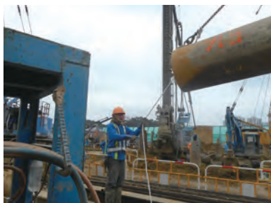
索具工手持引导绳，确保吊运过程安全。
