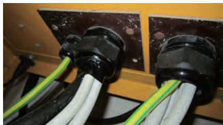
电线应妥善接驳，不得给带电部分外露。 Properly connected wiring (no exposure of live parts)
