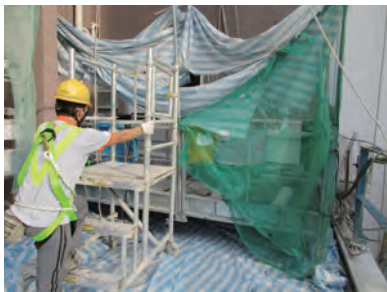
提供工人进入吊船的安全通道 Safe access to gondola
