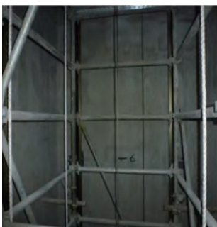
一共有三条救生绳，其中一条需靠近升降机槽入口处 3 lifelines provided with one close to the lift opening
