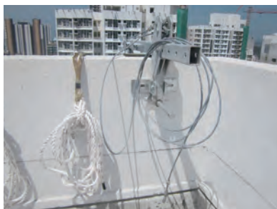
天台上的吊船设备。救生绳以布料、塑胶套管或类似的方法保护，以免被尖角损坏。
