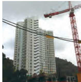
在一般情况下，不得在架空电缆附近进行吊运工作 Under normal circumstances, no crane operation allowed adjacent to overhead cables
