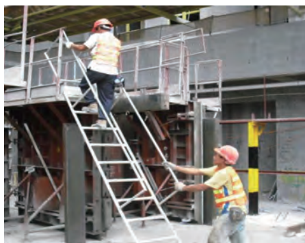
安全通道進入大型模板的工作平台
