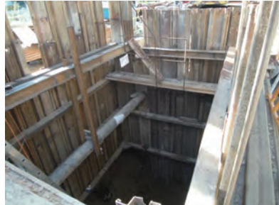
在挖掘工程中使用工字梁支撑水管 Water pipe supported by I-beam in excavation
