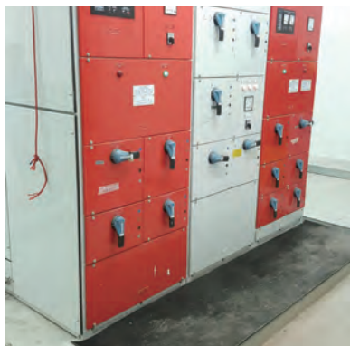
電力工作適用的絕緣蓆 An example of insulating mat
