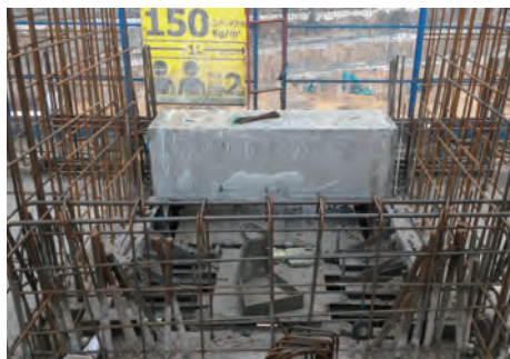
提供一個安全的工作平台上進行固定預製混凝土橫樑後，才進行吊運
