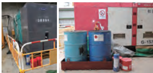
發電機裝置旁，應放置滅火器具
