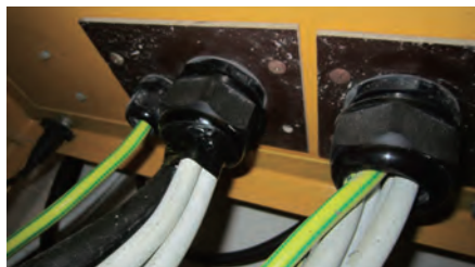
電線應妥善接駁，不得給帶電部分外露。 Properly connected wiring (no exposure of live parts)
