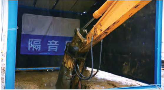
使用隔音屏阻隔產生的噪音 Noise shelter to screen the noise generated
