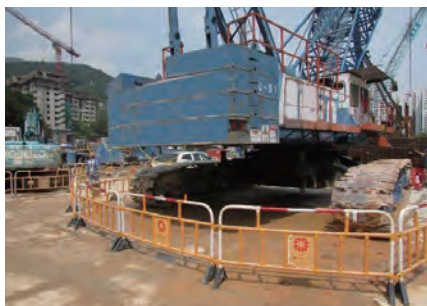
圍欄用以阻止其他人等進入正在工作中的重型機械的範圍 Fencing off the heavy machinery in use from persons' access
