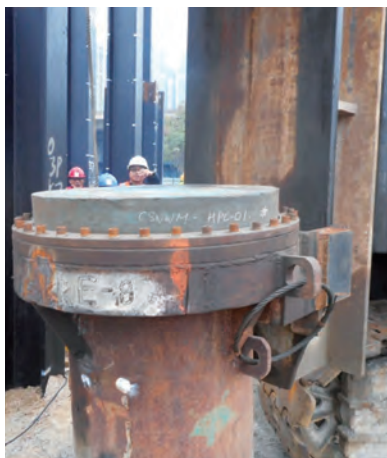
加設吊索以提升安全度（樁錘頭）
