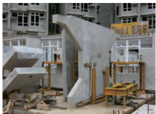
以鋼架穩固地承托預製組件
