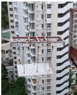
在吊運預製樓面板時，須正確安全地穩繫吊鉤於吊架上，才進行吊運 Fix properly anchor points of precast concrete slab to lifting frame
