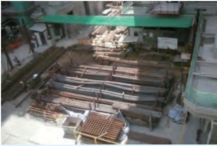
為紮鐵場提供伸縮性保護網 Foldable net provided above bending yard
