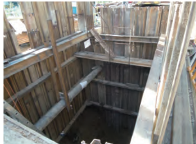
在挖掘工程中使用工字樑支撐水管 Water pipe supported by I-beam in excavation
