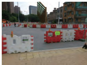
臨時行人過路安排·放置告示及路障·設定行人過路位置
