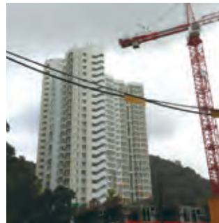
在一般情況下，不得在架空電纜附 近進行吊運工作 Under normal circumstances, no crane operation allowed adjacent to overhead cables
