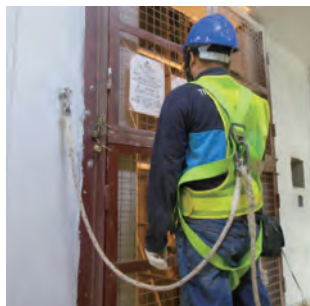
在升降機槽口附近設置錨固點，以供繫上防墮裝置／全身式安全帶。 Provide anchorage near lift shaft opening for anchoring fall arrestor/safety harness
