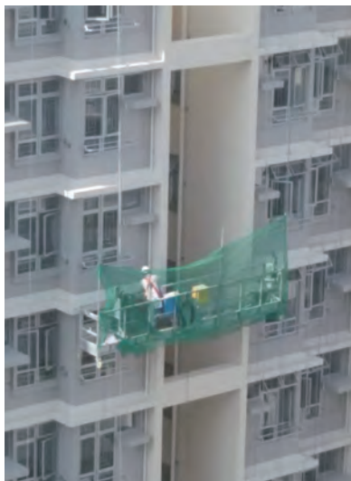
為吊船加上遲延燃燒物料造成的保護幕，以避免物料從高處下墜 Gondola provided with fire retardant protection screen to avoid falling of debris
