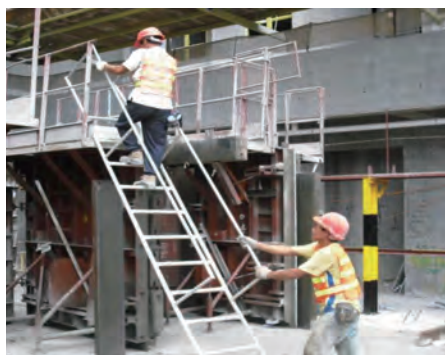
安全通道進入大型模板的工作平台
