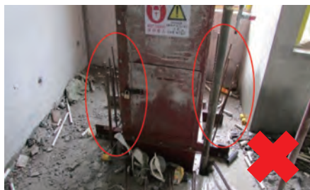
沒有保護突出的鋼筋
