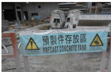
在鋪設硬地面的地方存放預製混凝土組件 Hard paved areas for storage of precast concrete products
