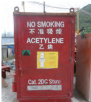
危險品倉庫（供貯存易燃氣體用） Dangerous goods store (flammable gas)
