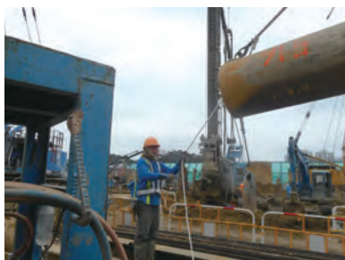
索具工手持引導繩，確保吊運過程安全。
