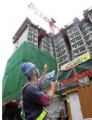
訊號員利用無線電溝通，以確保工序安全進行 Signaler using radio means for a safe lifting operation
