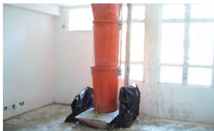
給突出的鋼筋提供安全保護
