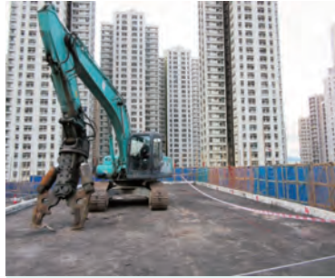
使用低噪音油壓器械進行拆卸工作 Low noise hydraulic breaker for demolition works
