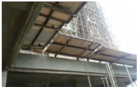
在大廈的第七層樓板工作尚未展開前，應完成設置大廈的臨時保護篷
