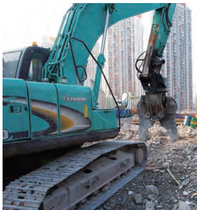
使用合適的重型機械進行拆卸工程 Suitable heavy machinery for demolition works
