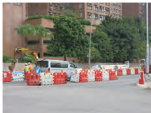
臨時行人過路安排·放置告示及路障·設定行人過路位置
