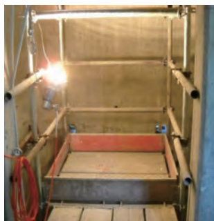
安全通道進入升降機槽的工作平台 Proper access to working platform in lift shaft
