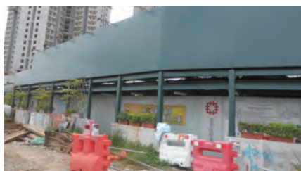
在行人道上架設雙層圍板 Double-deck hoarding over pavement
