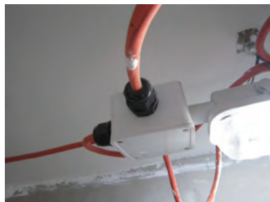
裝置需有保護帶電的部分，防止意外被觸及 Live parts protected/insulated
