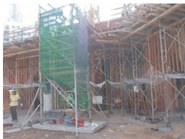
工作架上裝設安全網，減少人體下墜時所受的傷害
