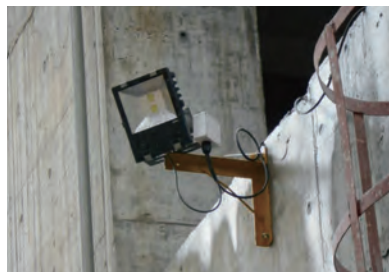
在室外安裝的照明裝置，需選用有防水功能的型號 Waterproof lighting at external area
