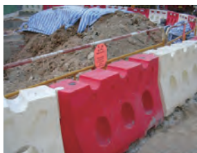
在挖掘工程邊緣設置的另一款圍欄，並掛上的警告標誌 Warning sign affixed to fencing along the edge of the excavation
