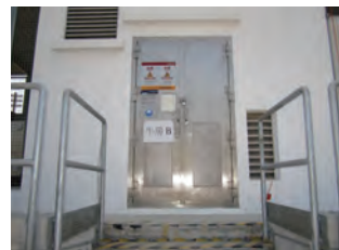
有通暢及方便出入通道的變壓器房／臨時電掣房
