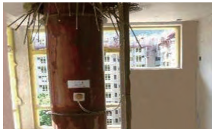
垃圾槽設有指示器，提醒其他使用者垃圾槽正在使用中
