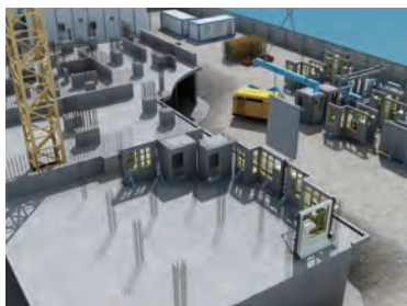
利用建築信息模擬技術說明各類型預製單位的貯存和安裝情況，可示範預製組件的貯存、吊運和安裝工程
