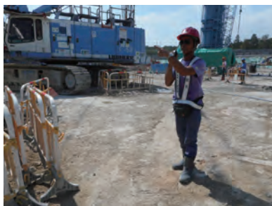
訊號員手持電子通訊儀器，確保吊運過程順利／安全。
