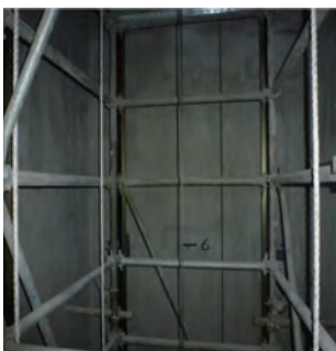
一共有三條救生繩，其中一條需靠近升降機槽入口處 3 lifelines provided with one close to the lift opening
