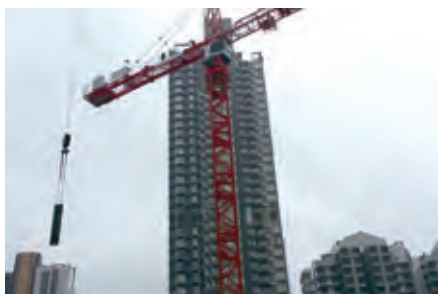
架設中的塔式起重機 Erection stage of tower crane
