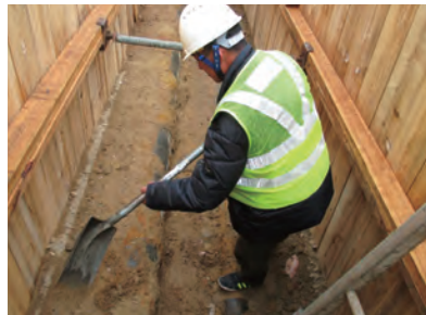
工人以人手挖掘，以免意外損毀公用設施。 Hand digging to avoid accidental damage to utility
