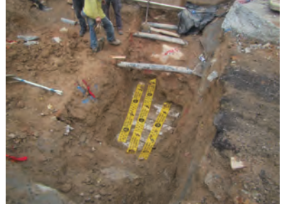
在懷疑有地下公用設施地點進行挖掘，應以手工具協助 Only hand-dug method allowed to locate the exact underground services
