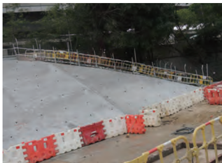
為大型挖掘工地提供適當的出入口 Adequate access and egress from mass excavation
