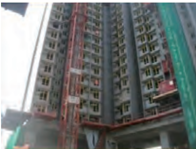
在大廈的第七層樓板工作尚未展開前，應完成設置大廈的臨時保護篷
