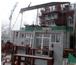
使用有足夠支持點的工字起重樑給預製外牆固定後，才進行吊運 Hoisting I-beam with supporting points to lift precast concrete facades
