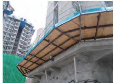
設置臨時保護篷，為工人提供安全的進出通道
