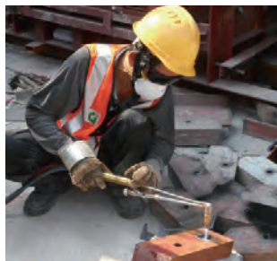
曾受訓練的焊工在進行火焰切割／電弧焊接時佩戴個人防護裝備，例如護目鏡、面罩、手套等。
