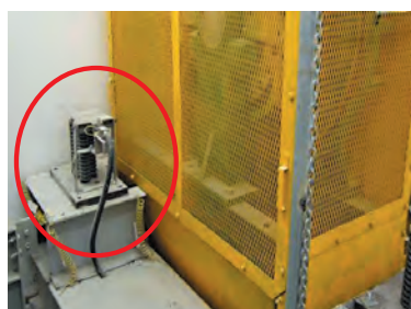
Slack rope switch
