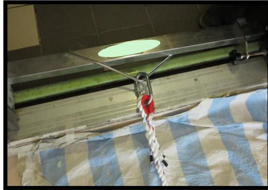
如工作地點沒有可使用的固定繫穩物及其他有效方法連接防墮安全裝備進行高處工作，便可考慮使用橫杆式和掛牆式流動式臨時防墮繫穩裝置，安裝以上兩種流動式臨時防墮繫穩裝置時，須根據生產商的規格及指引，並須由合資格的人監督及檢查。在任何時間內，每件流動式臨時繫穩裝置只可容許一人使用。
