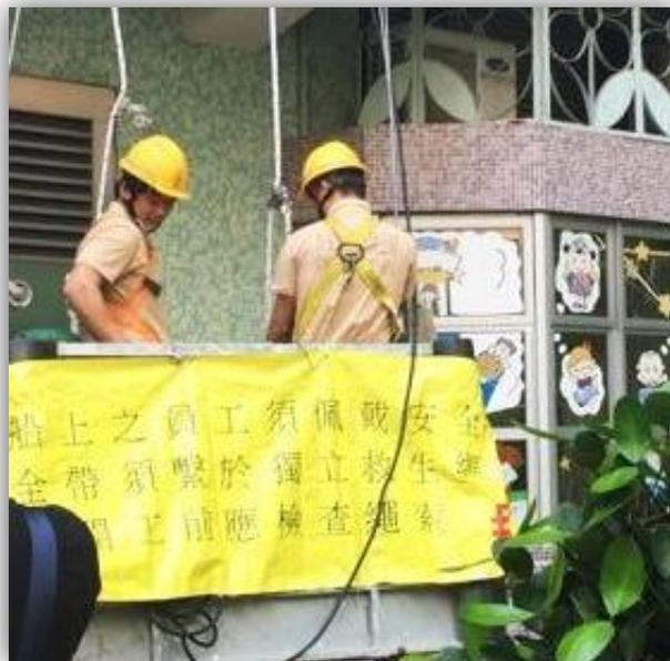
9. 於吊船上顯眼處展示告示，註明安全操作負荷，限載人數及纜索的檢查，並同時提醒工人佩戴所需之個人防護裝備。
