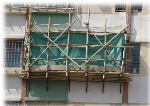
3. 使用合適的繫穩螺絲安裝「狗臂架」，鑽孔的直徑不可過大，其深度亦不可過淺，並須鑽入堅固的外牆混凝土結構中。而每個「狗臂架」必須裝上三顆或以上的繫穩螺絲。
