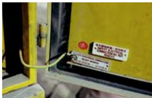
所有接地線應掛上適當標籤及妥善接駁至總接地終端後，並連接到接地棒
