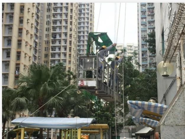
2. 吊船必須由「合資格人士」在緊接使用前的 7 天內作檢查，並填寫報表格一。
