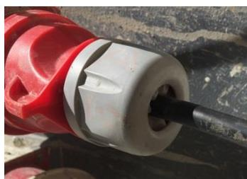
插座內的電線應妥善接駁於接線座，電線不得外露
