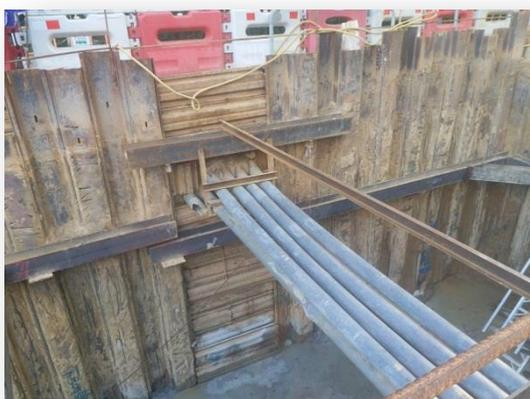
5. 在進行路面或地下工程期間，應提供安全及穩固的上落通道。重大改動及惡劣天氣後（例如：大風或大雨後），必先等「合資格人士」檢查坑穴的穩定程度完畢後才可繼續挖掘，挖掘前先泵出坑內積水。
