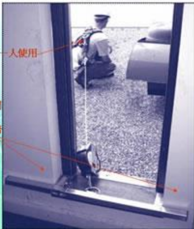
流動性臨時防墮繫穩裝置 連接伸縮式防墮裝置
